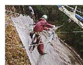
トラップボルトを導入し、支柱昇降作業が安全にできる。
