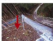
上段横ロープを支柱頭頂部に設置するので偏心しない。
